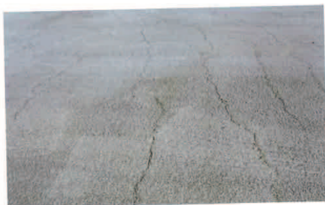
Betongyta där vattnet har fått avgå för snabbt från betongmassan så att det har uppstått plastiska krympsprickor.
