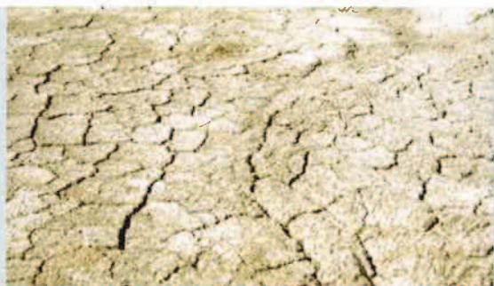
Leran spricker när den blir torr ...
