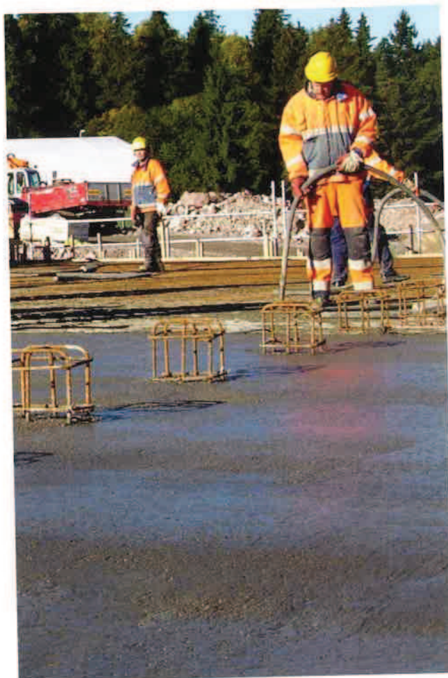
Betongen ska hårdna och torka i en naturlig takt. Om vattnet i betongmassan avgår för snabbt uppstår plastiska krympsprickor.
