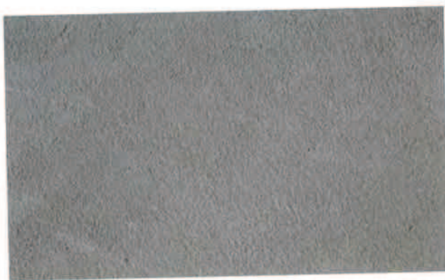
Perfekt gjuten och behandlad betongyta.
